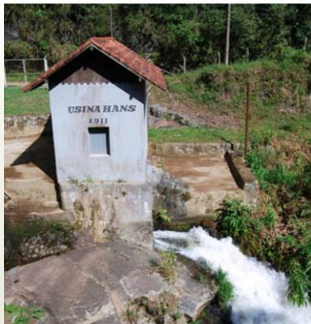
A centenária Usina Hans, 1911, fornecia eletricidade a fábricas de N. Friburgo - RJ
